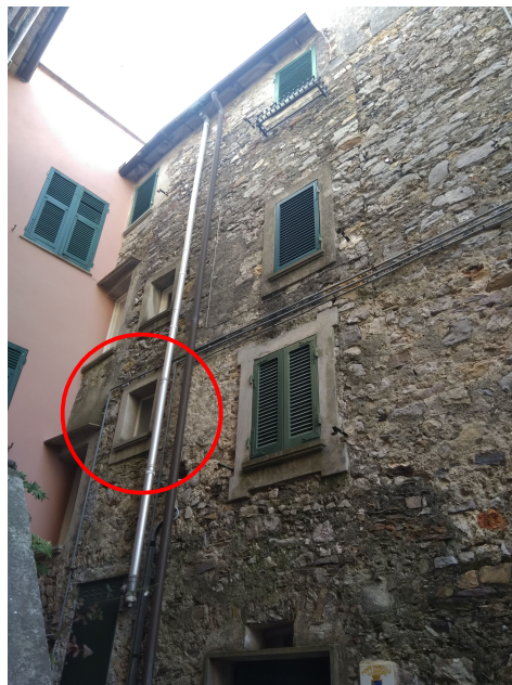
Foto 4: Vista di dettaglio apertura su scala comune
