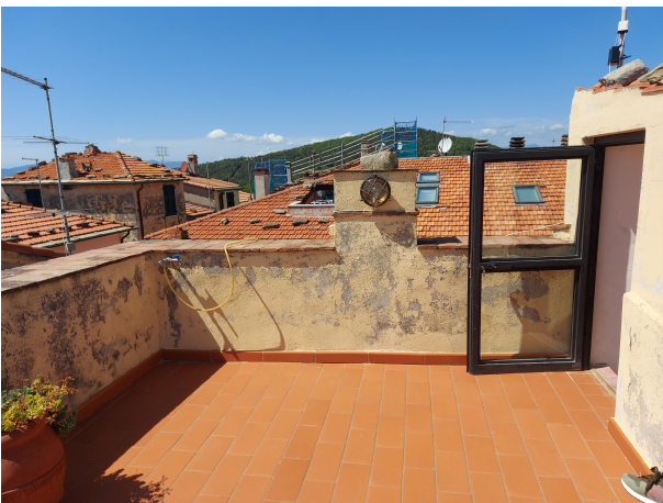
Foto 2: Vista del terrazzo/lastrico solare lato Nord
