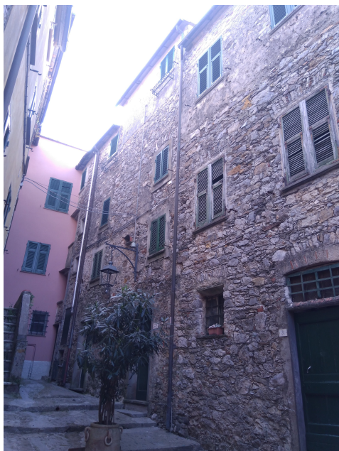
Foto 3: Vista dell'immobile da Via delle Mura lato Sud (Piazzetta)
