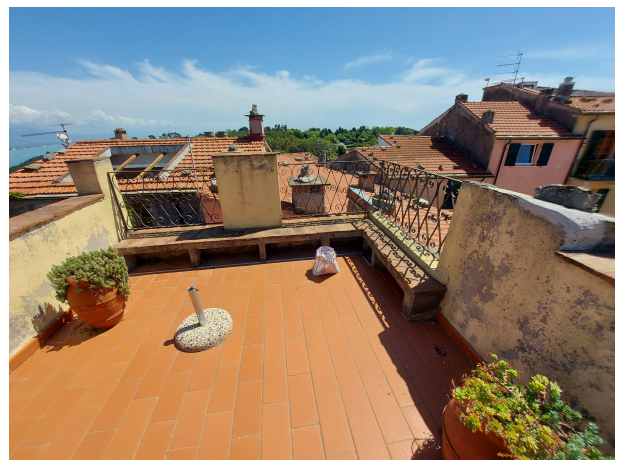
Foto 1: Vista del terrazzo/lastrico solare lato Sud
